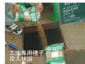
モンテューリキッドカーボン投入状況
